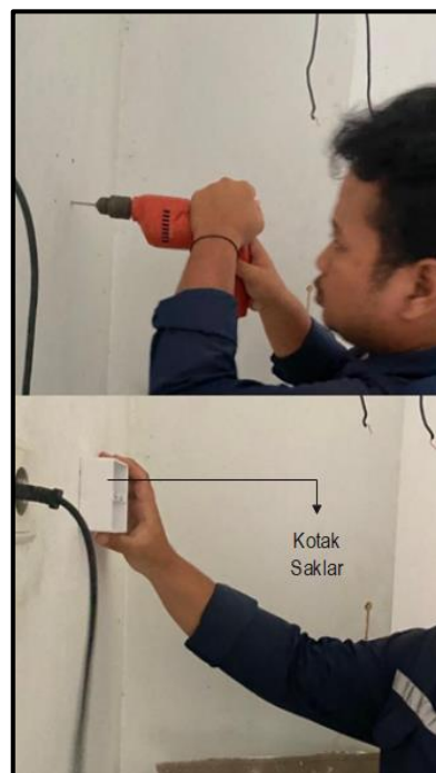
Gambar 4. 16 Pemasangan Kotak Saklar
