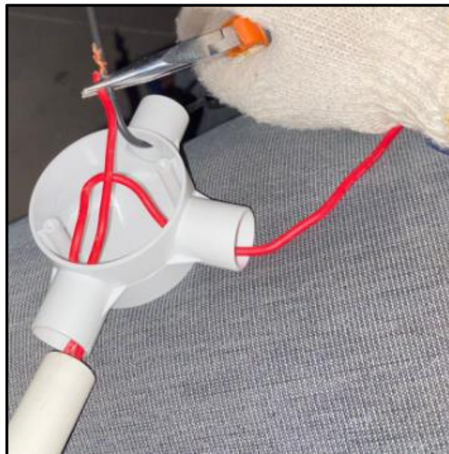
Gambar 4. 13 Pembuktian Penyambungan Pigtail
