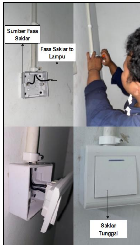
Gambar 4. 17 Pemasangan Saklar Tunggal
