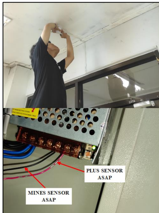
Gambar 4. 22 Pemasangan Power Supply Ke Sensor Asap
