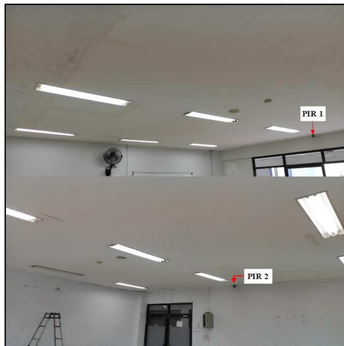
Gambar 4. 20 Pengujian Sensor PIR Ke Lampu
