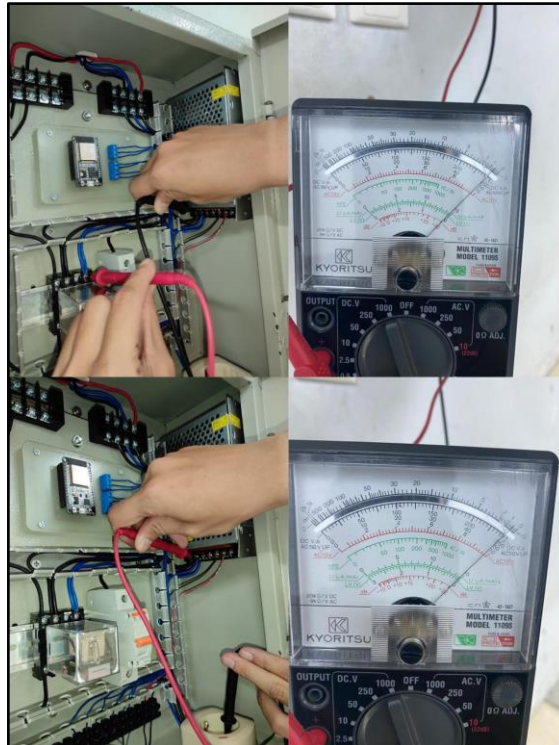
Gambar 4. 29 Pengujian Kontiniti Menggunakan Multimeter Analog
