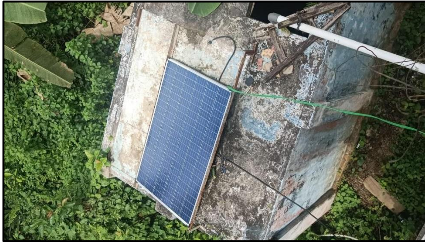
Gambar 4.4 Pemasangan panel surya
