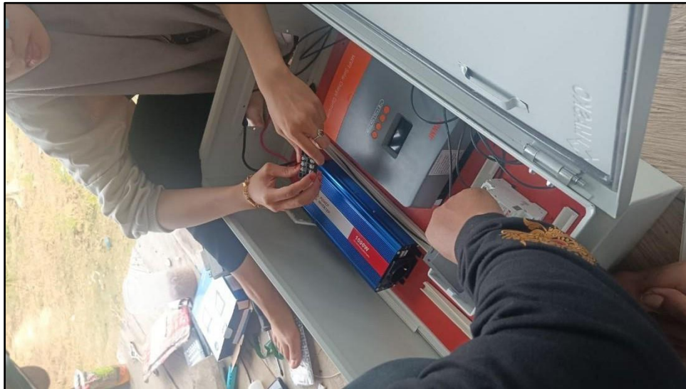
Gambar 4.2 Pemasangan kabel MCB ke Inverter
