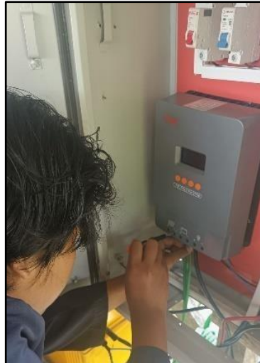
Gambar 4.5 Pemasangan kabel panel surya ke SCC
