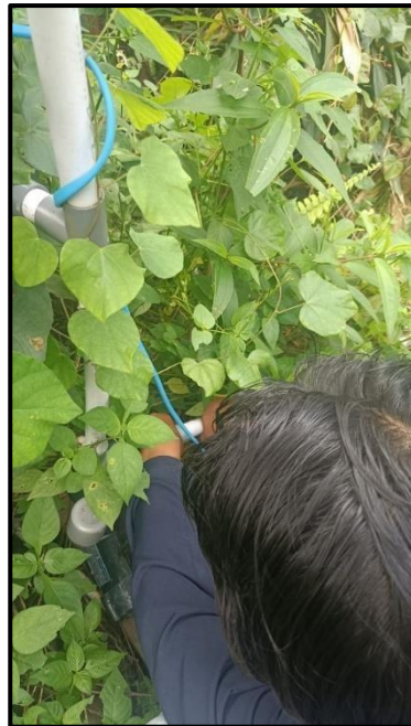
Gambar 4.7 Pemasangan pipa dari sumur menuju ke pompa air
