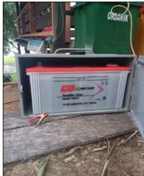
Gambar 4 6 Pemasangan Mppt Ke Baterai/Aki
