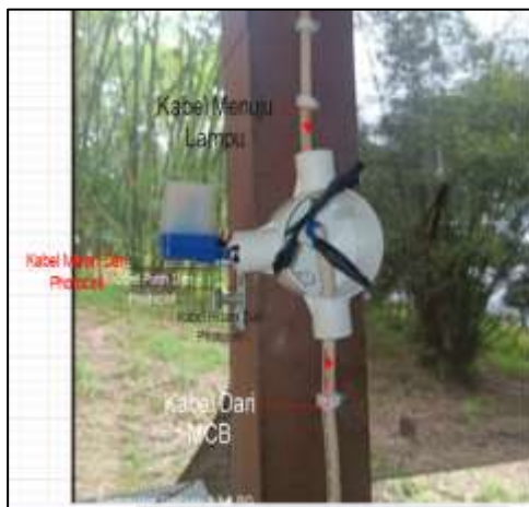
Gambar 4 14 Pemasangan Photocell
