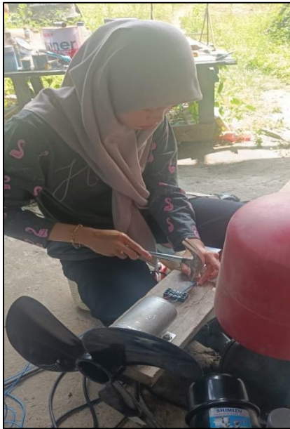
Gambar 4.2 Pemasangan Generator DC ke Aki
