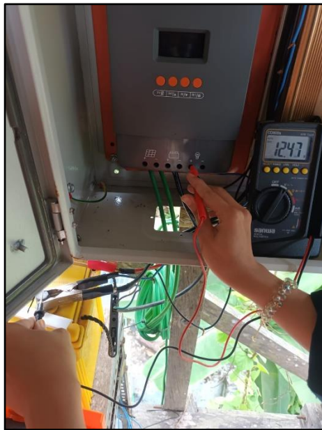
Gambar 4.13 Pengukuran Tegangan Beban saat kincir angin berputar
