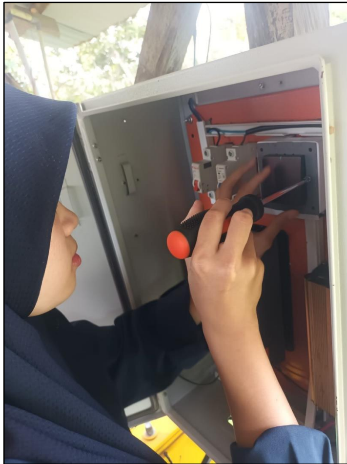
Gambar 4.6 Pemasangan Saklar pada Lampu
