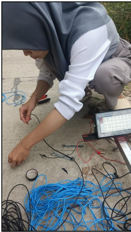
Gambar 4.4 Pemasangan lampu pada tiang
