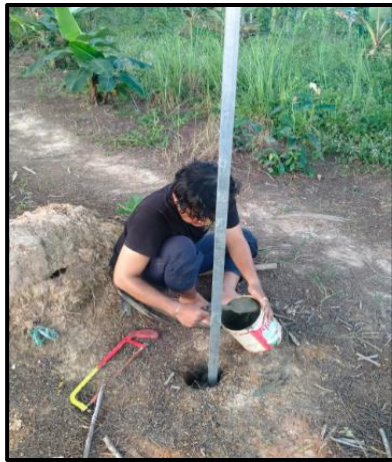
Gambar 4. 23 Pemasangan Tiang Lampu 1
