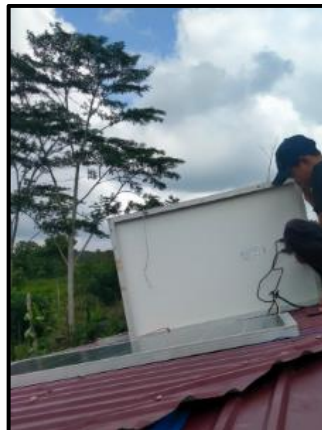
Gambar 4. 5 Penyambungan 3 Panel Surya Secara Seri
