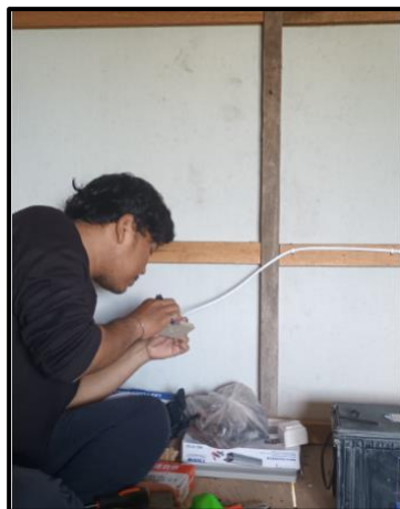
Gambar 4. 15 Merangkai Stop Kontak
