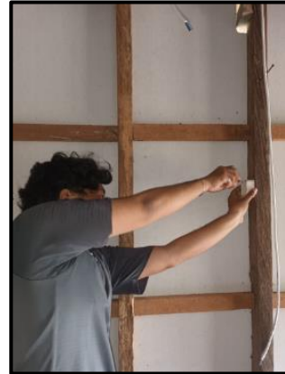
Gambar 4. 18 Pemasangan Saklar
