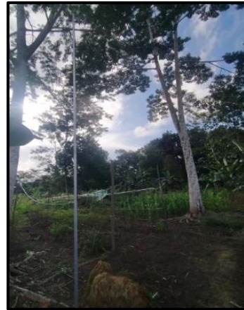
Gambar 4. 24 Tiang Lampu 1 Terpasang
