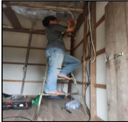
Gambar 4. 17 Instalasi Pengkabelan Lampu
