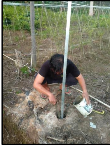
Gambar 4. 25 Pemasangan Tiang Tiang Lampu 2
