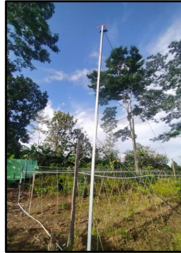
Gambar 4. 26 Tiang Lampu 2 Terpasang
