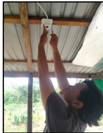
Gambar 4. 20 Pemasangan Fitting Lampu Di Teras
