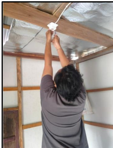
Gambar 4. 19 Pemasangan Fitting Di Dalam Ruangan
