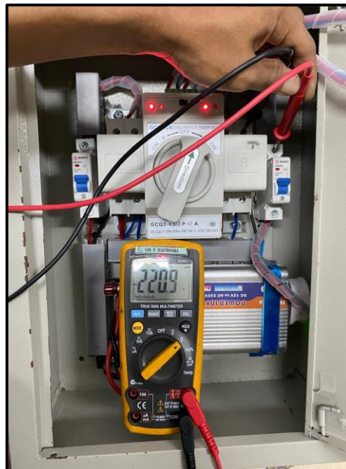
Gambar 4. 13 Arus Dari Baterai aki yang masuk ke Inverter
