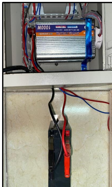
Gambar 4. 2 Wiring Aki 20Ah ke inverter 1000Watt
