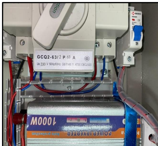
Gambar 4. 8 Wiring ATS kebeban lampu
