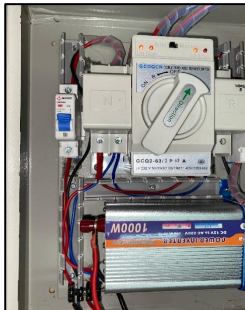
Gambar 4. 6 Wiring ATS 220VAC ke Tegangan PLN
