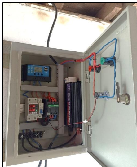
Gambar 4.12 Pemasangan dari Kontaktor ke Volt and Ampere Meter , Lampu Indikator dan Stop Kontak
