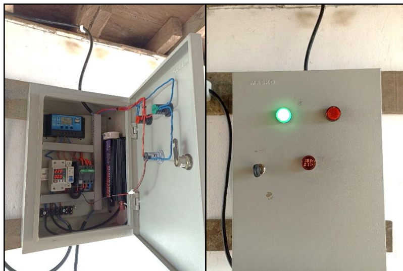
Gambar 4.14 Hasil pemasangan keseluruhan alat
