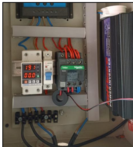
Gambar 4.6 Pemasangan dari Inverter Pure Sine Wave 1000 Watt ke MCB 1 Fasa
