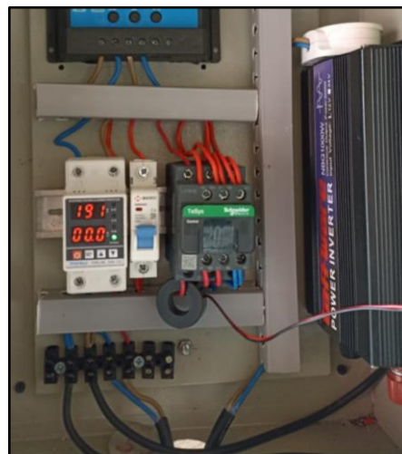
Gambar 4.8 Pemasangan dari MCB 1 Fasa ke Over and Under Voltage Protection
