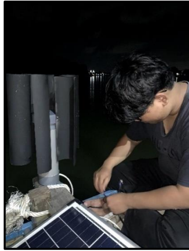
Gambar 4. 10 Pemasangan Kincir Angin di kapal
