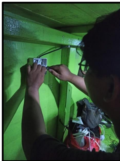
Gambar 4. 11 Pemasangan Saklar
