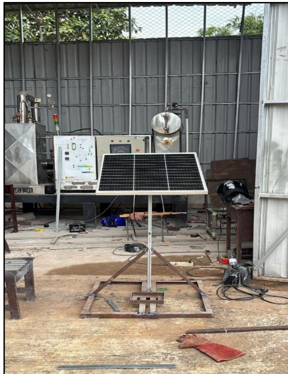
Gambar 4. 1 Perakitan dudukan sel solar panel surya 100 wp
