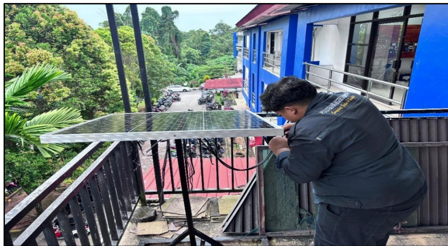
Gambar 4. 2 pemasangan kabel output menuju scc
