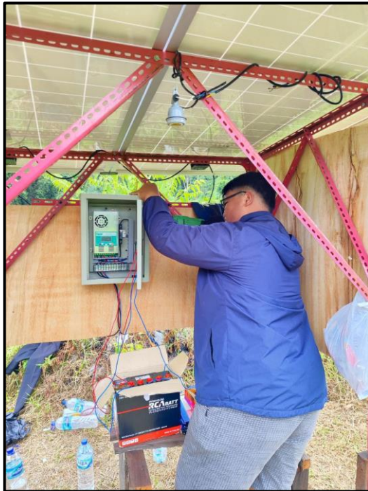
Gambar 4.5 Pemasangan Inverter 2000 Watt
