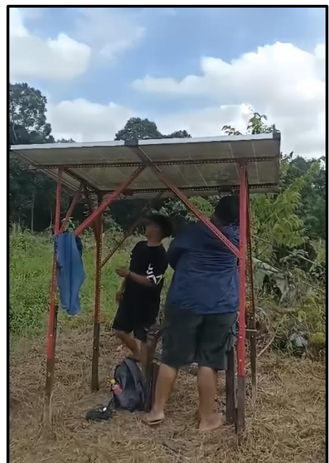
Gambar 4.2 Pemasangan Solar Panel
