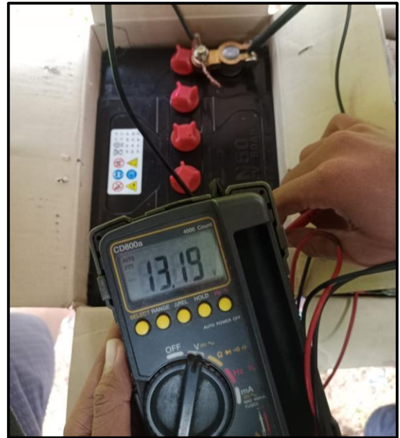
Gambar 4.4 Pengecekan Aki menggunakan Multimeter
