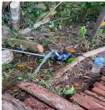
Gambar 4.9 Pengujian Pompa Air
